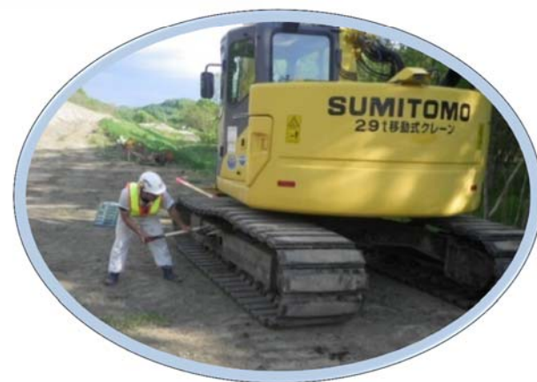
跡片付け終業時点検を実施
