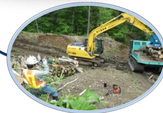
測量や現場の管理をします
